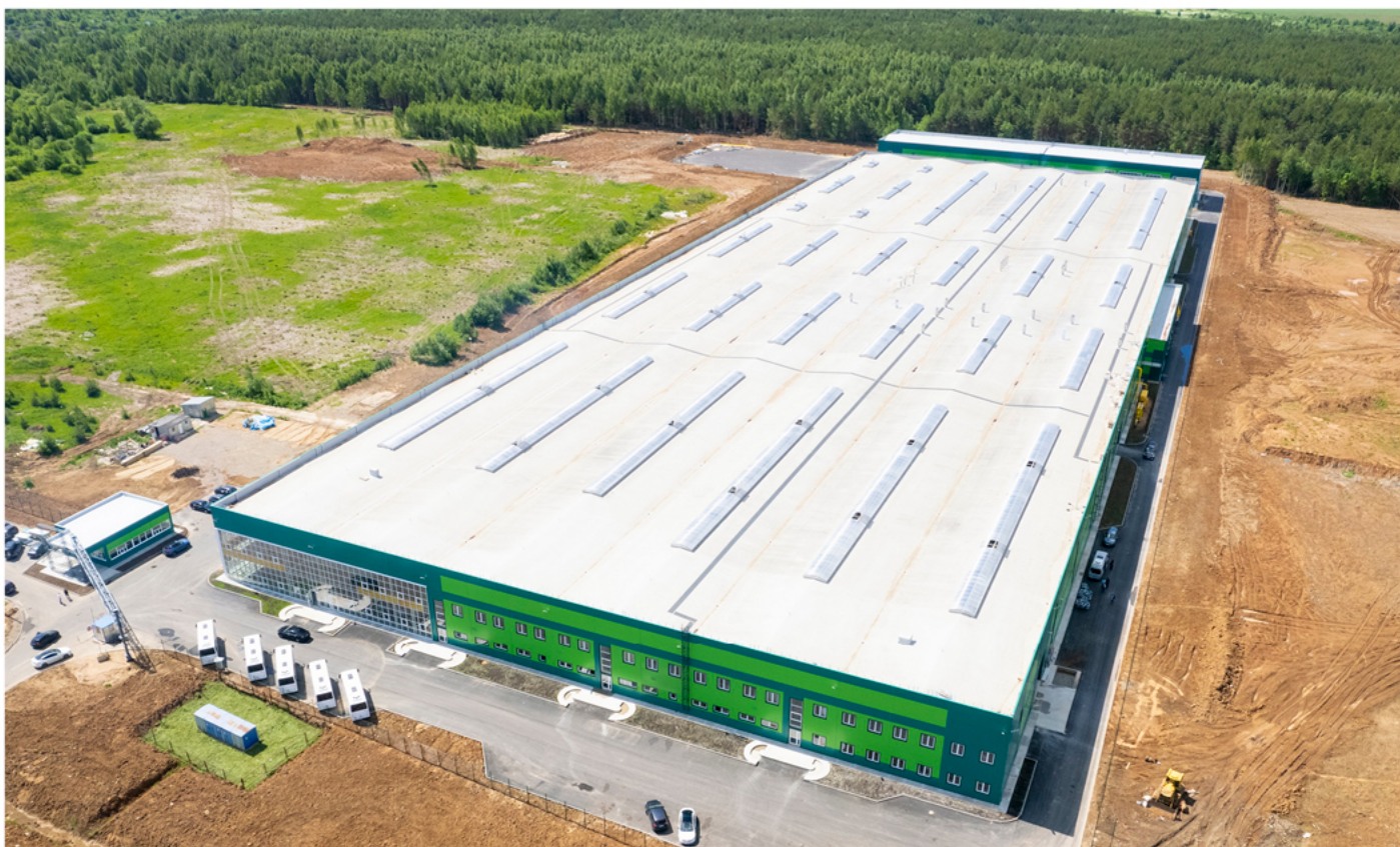
Производственный корпус «Унтекс Родники» на этапе строительства
